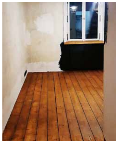
Prkennou podlahu jsem opatřil dvěma vrstvami dekoračního vosku Osmo v odstínu dub a poté dvěma vrstvami tvrdého voskového oleje Osmo v provedení hedvábný polomat
