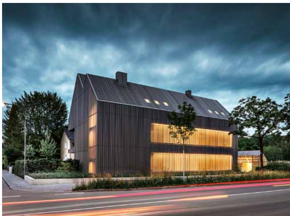
U rušné silnice může být fasádní obklad součástí protihlukových opatření. Průhledný (případně rovnou skleněný) obklad pak může přispívat i k solárním ziskům (PREFA)
