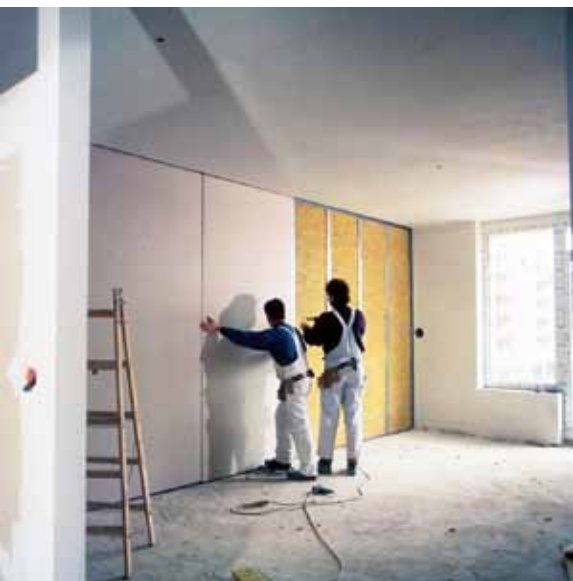
Sádkartonové desky se využívají i v systémech přesazených stěn pohlcujících zvuk v interiéru (KNAUF)
