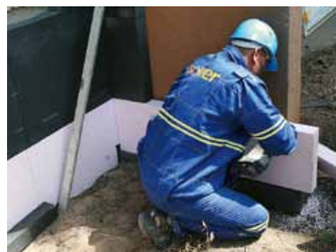
Soklové izolační desky Isover EPS Sokl 3000 jsou speciálním typem EPS desek napěňovaných do forem pro náročné tepelné izolace konstrukcí v přímém styku s vlhkostí (ISOVER)
