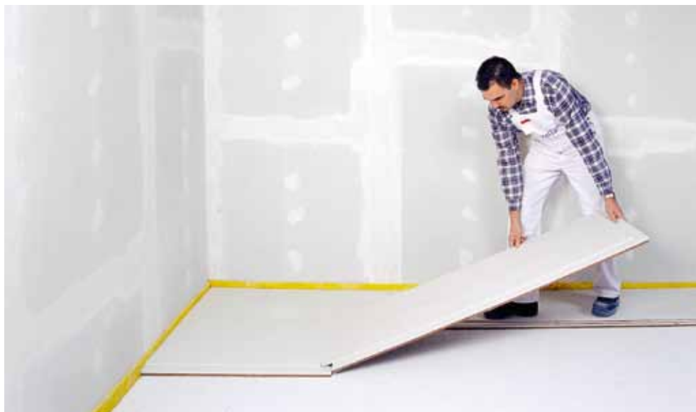
Sádrovláknitá podlahová deska fermacell E25, typ 2E22 1500 × 500 × 25 mm s polodrážkou (FERMACELL)
