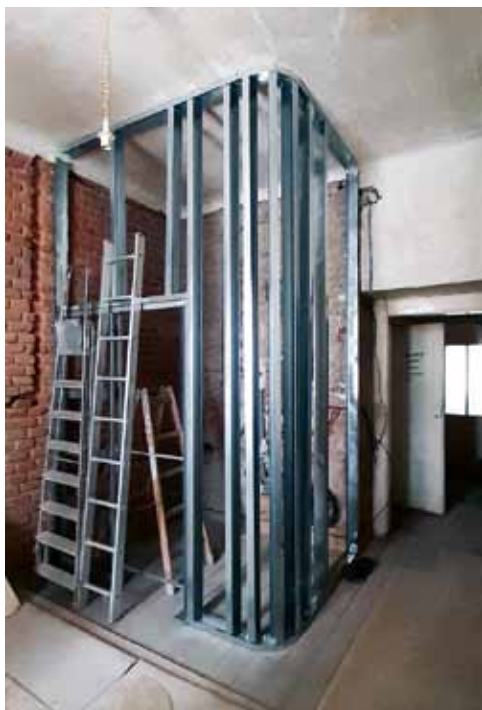
S ohledem na snadnou montáž a lehkou konstrukci je šatna vybudována ze sádkartonu
