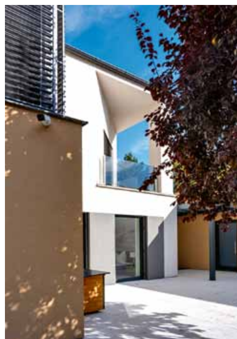
Garáž se při rekonstrukci zvětšila a prostřednictvím přístavby wellnessu a zázemí propojila s domem. Přízemní blok sahá od uliční čáry až dozadu do zahrady
