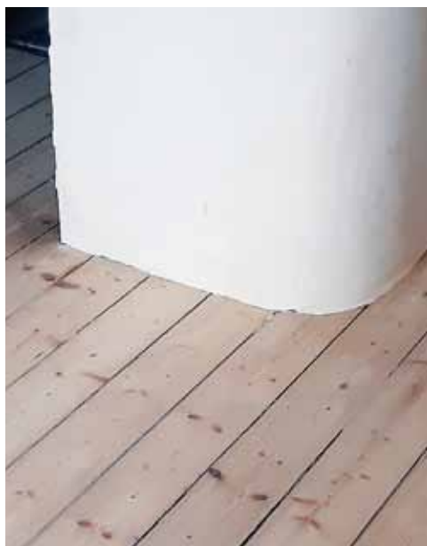
Prkenná podlaha byla několikrát celoplošně zbrúšena až na čisté dřevo
